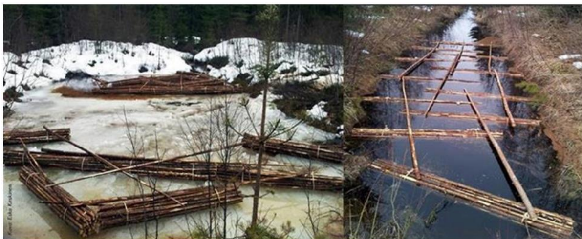
Fotod 3. ja 4. Näiteid puittõkestistest settebasseinides („Maaparandussüsteemide negatiivsete mõjude leevendus- ja kompensatsioonimeetmete rakendamise juhis. Täiendatud versioon.“)
